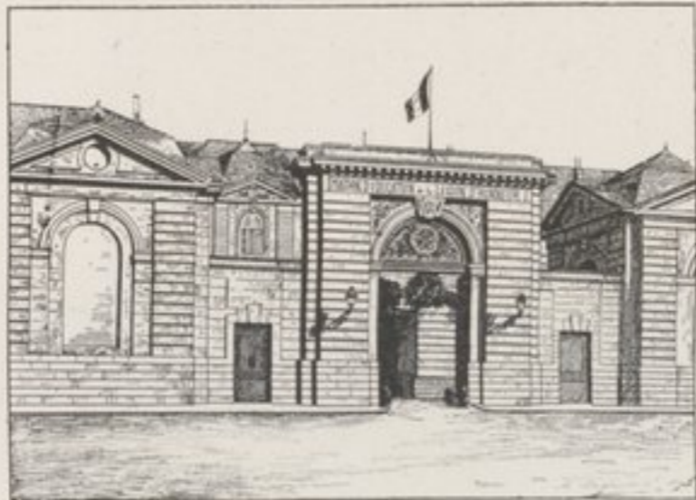
Entrée de la maison de Saint-Denis.
